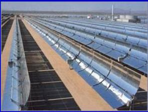
**Vorbild: Solare Parabolrinnen-Anlage in der Mojave Wüste, Kalifornien 354 MW elektrische Leistung**
